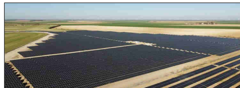
Planta Fotovoltaica Samoussy, Francia
