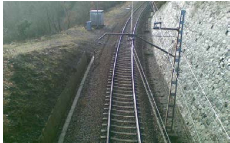
Rehabilitación de vía en el tramo Amurrio-Llodio
