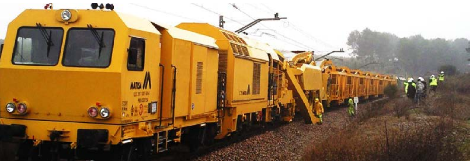
Operaciones de desguarnecido de vía. MATISA C-75
