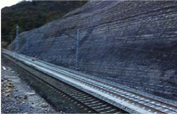
Intervención por desprendimiento en la línea Castejón-Bilbao
