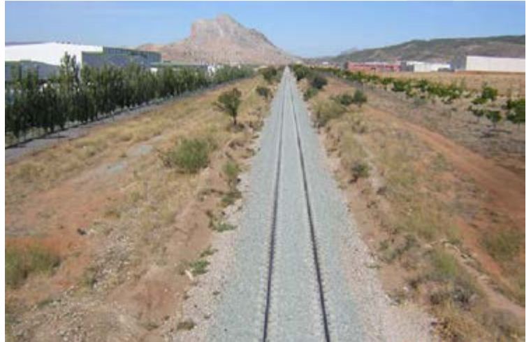
Renovación de vía tramo Antequera-Loja
