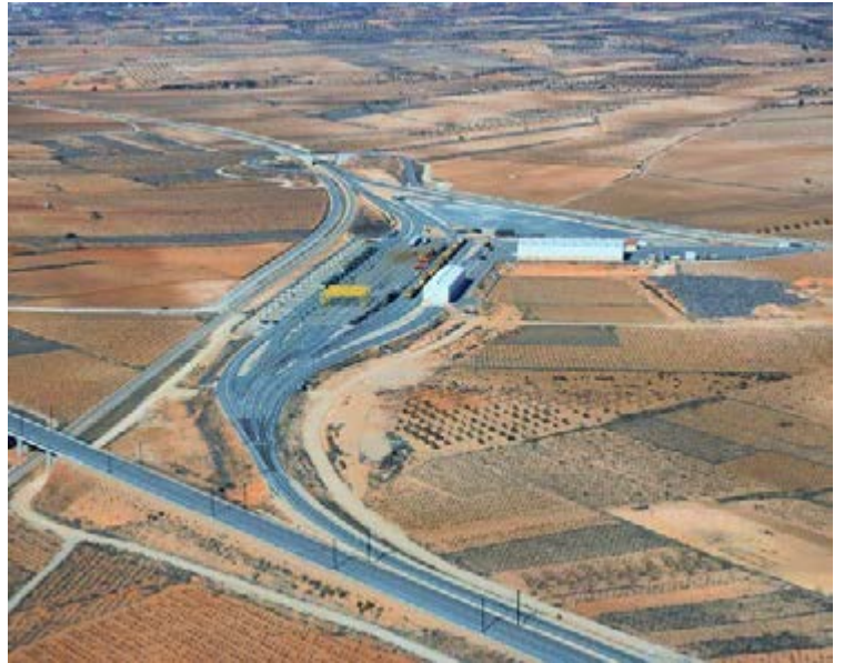
Mantenimiento de infraestructura, vía y desvíos línea Alta Velocidad a Levante
