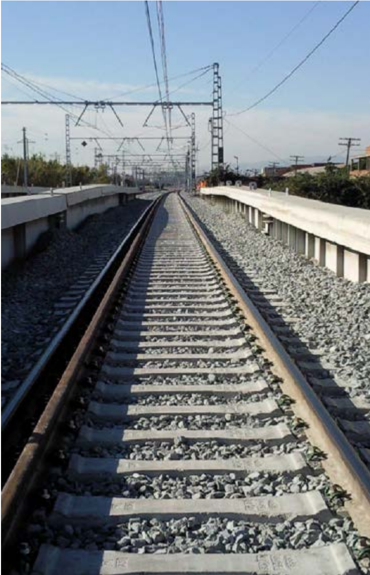
Instalación del tercer hilo electrificación del ramal de Can Tunis, Barcelona
