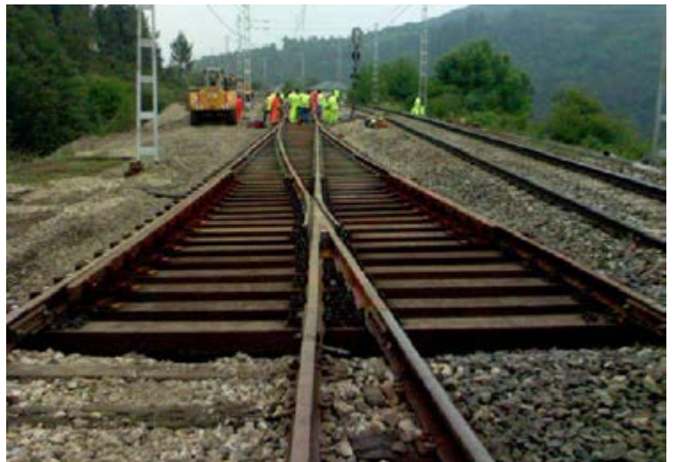
Montaje de desvío en la estación de Freixeiro, Orense
