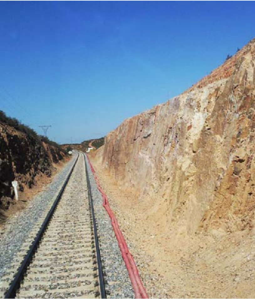
Tratamiento de trincheras en el tramo Zamora-Carbajales
