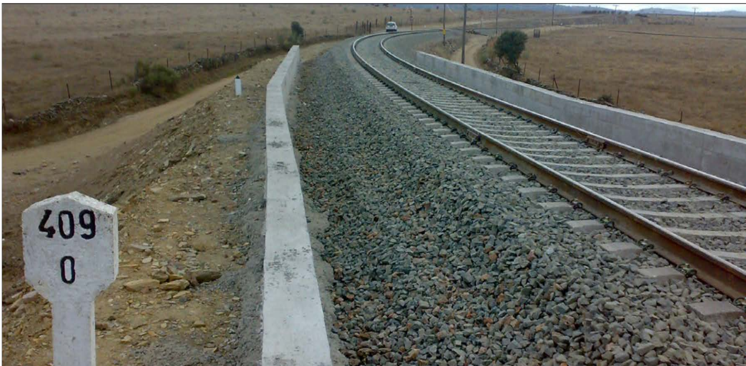
Renovación de vía tramo San Vicente-V. Alcántara
