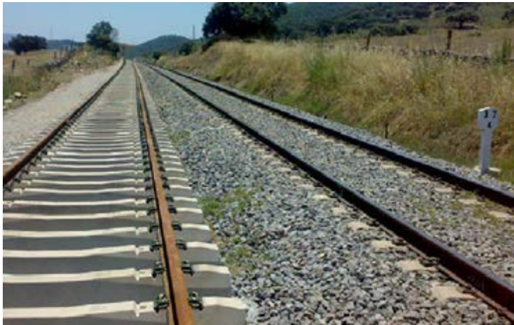
Trabajos de ampliación de vía
