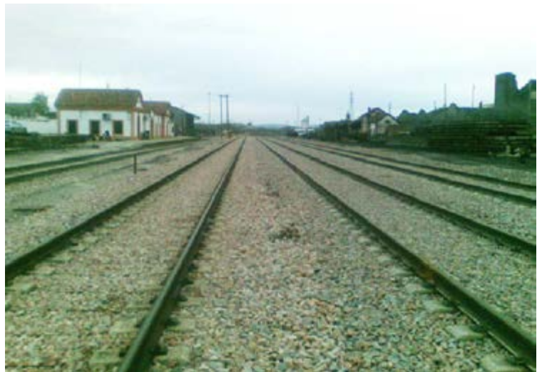
Rehabilitación de vías en la estación de Peñarroya, Córdoba
