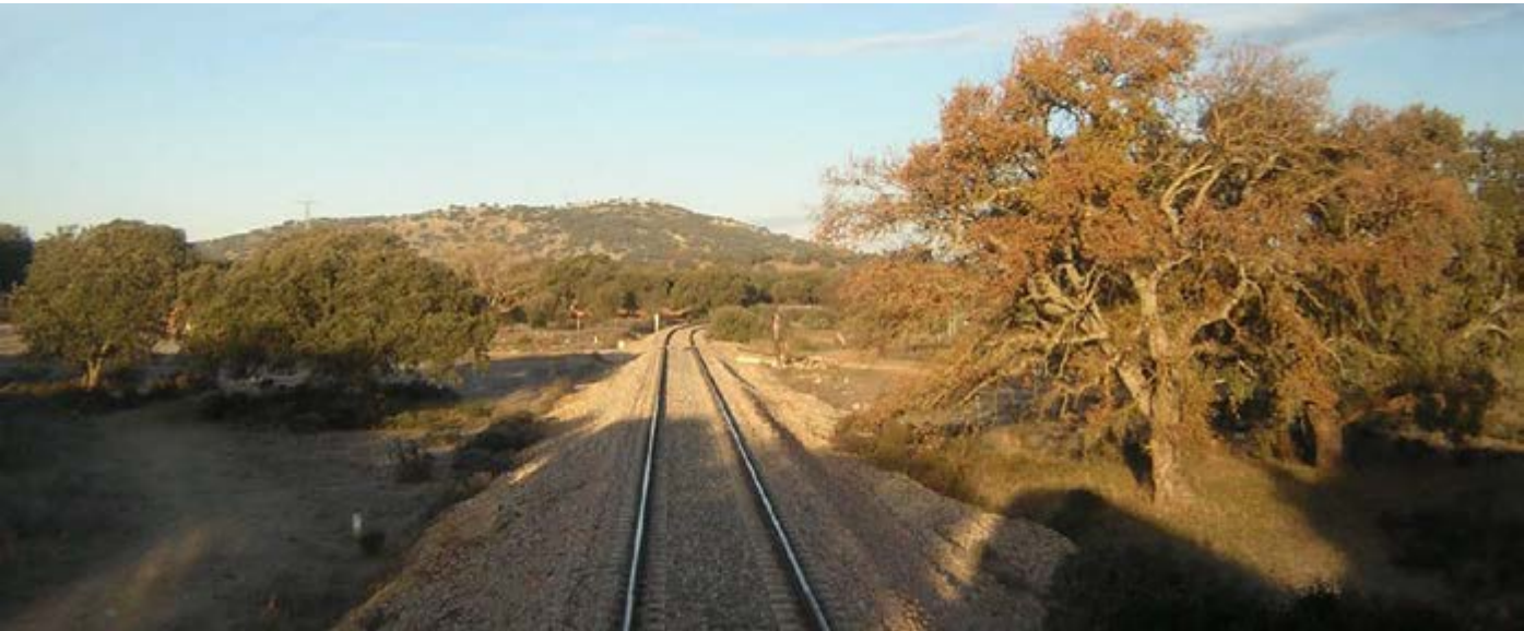
Rehabilitación de vía en el tramo Antequera-Loja
