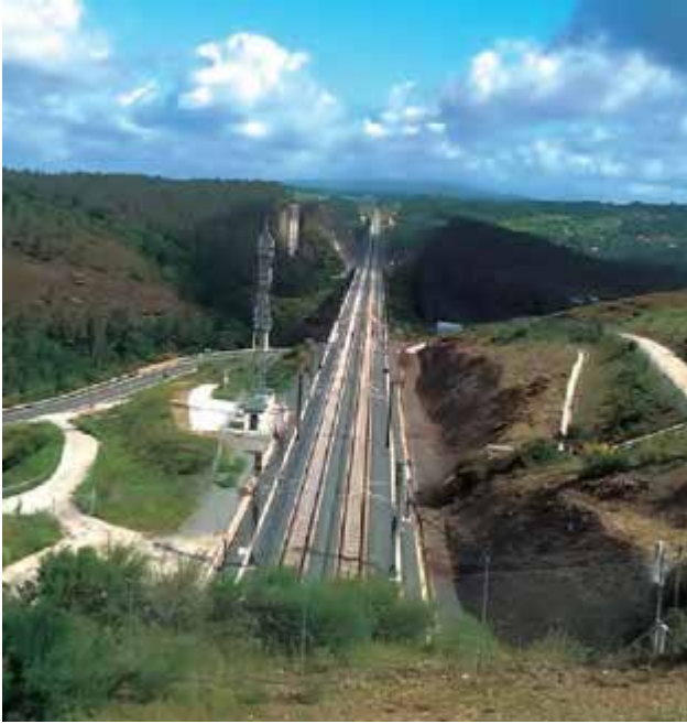
Prevención de incendios en la red convencional de ADIF, Lote 6, Dirección Noroeste.
